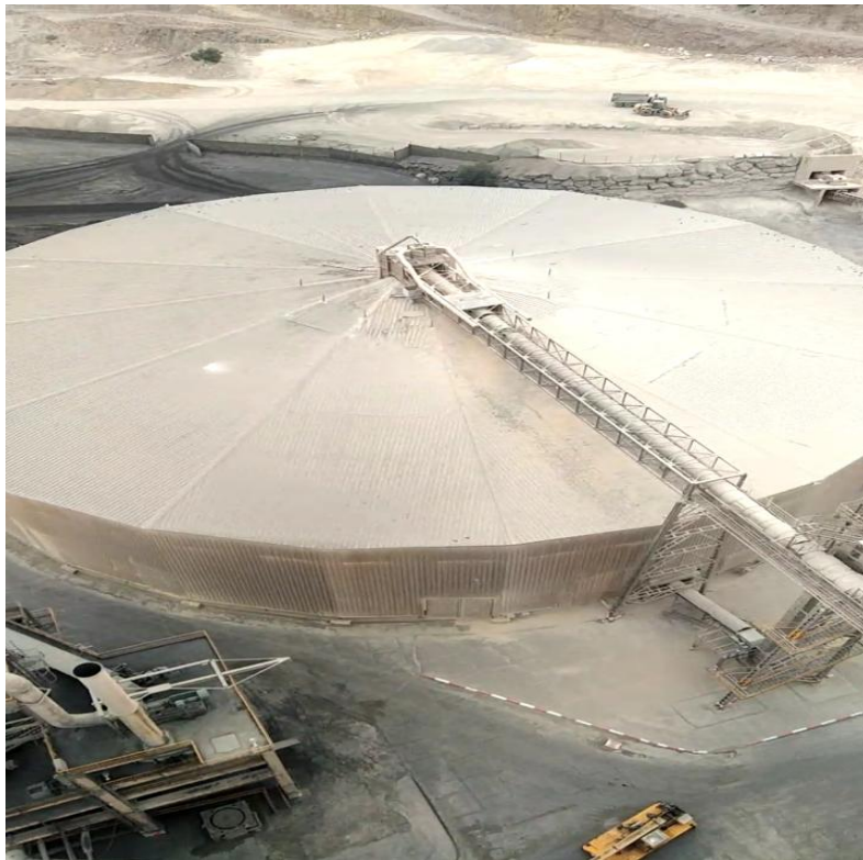
Figure 6 : Hall de stockage de la matière concassée
