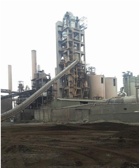
Figure 10 : La tour échangeur
