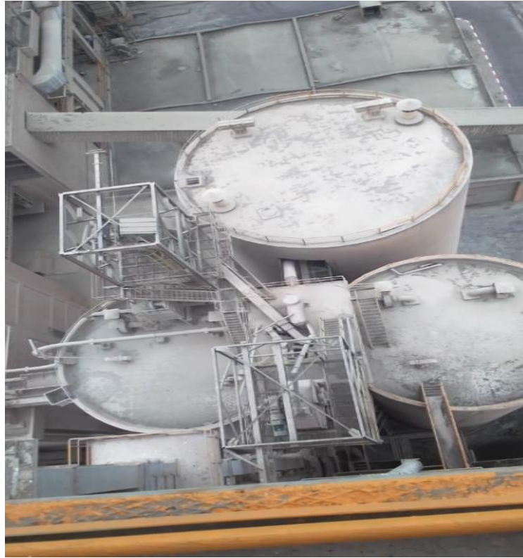
Figure 9 : Silos d'homogénéisation et de stockage
