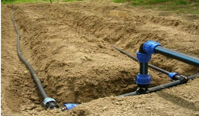
L'irrigation au goutte à goutte consiste à amener l'eau sous pression dans un système de canalisations, généralement en PVC; cette eau est ensuite distribuée en gouttes au champ par un grand nombre de goutteurs répartis tout le long des rangées des plantations. Les
