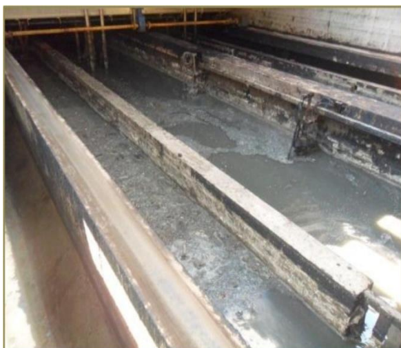
Fig 7 : Ouvrage de dessablage.
