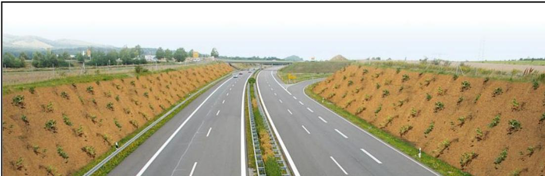
*Photo 10: Technique des paillages au niveau des talus routière*
