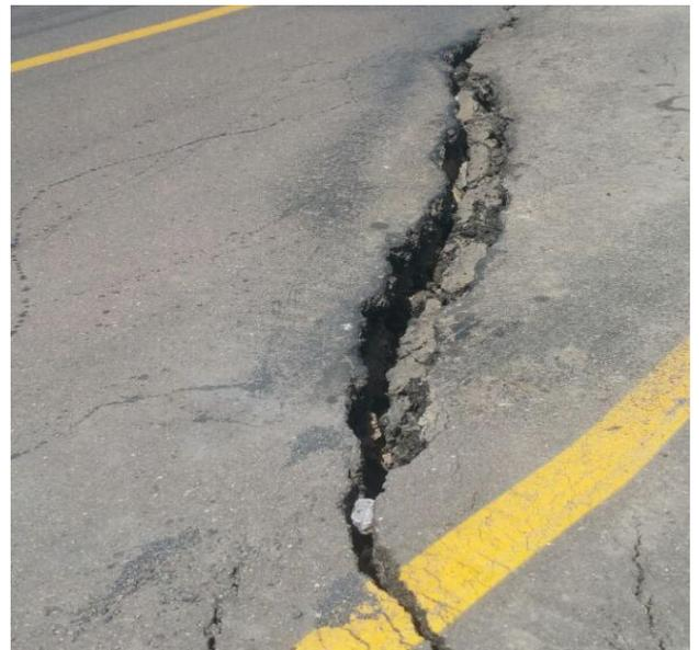
Photo 13 : fracture dans la route au niveau de la zone 2
