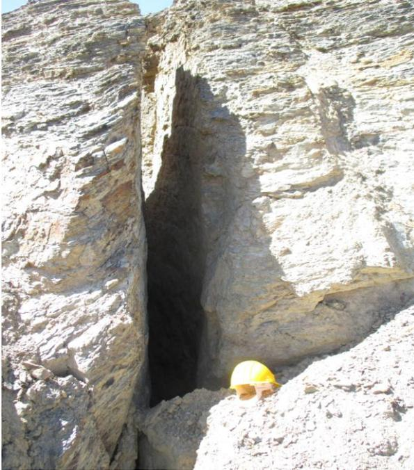
Photo14 : une grande fissure au niveau de la zone 3
