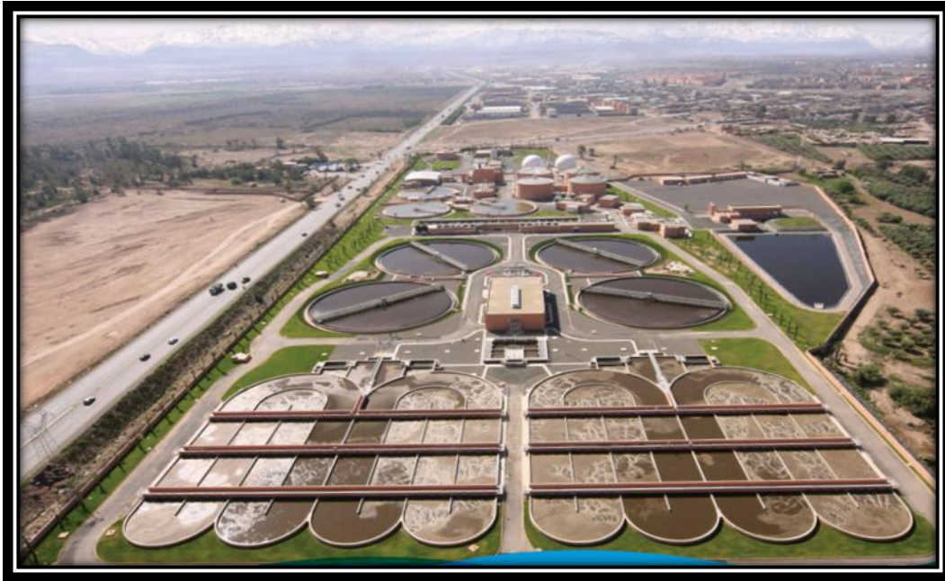
Figure 5 : Station d'épuration des eaux usées.
