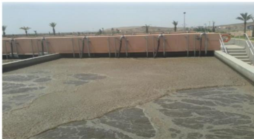
Figure 9 : Bassin d'aération (ou bassin biologique).
