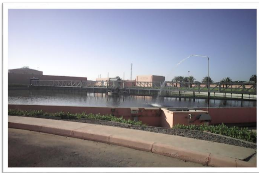
Figure 10 : clarificateur.
