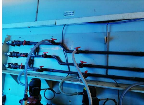
Figure 28: Pompe doseuse du sulfate d'alumine
