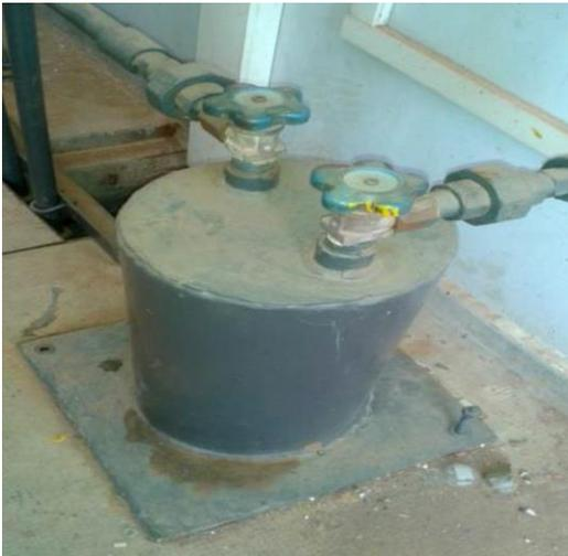
Figure 40 : Piège de chlore
