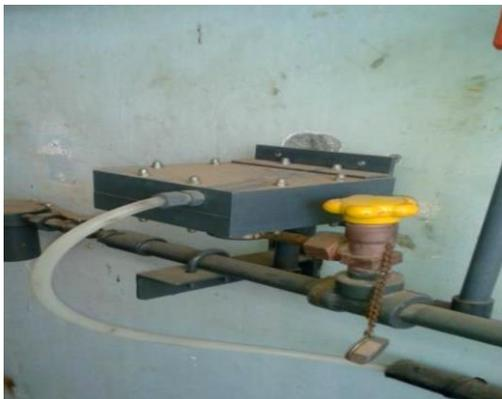
**Figure 36 : Régulateur de vide (détendeur)**
