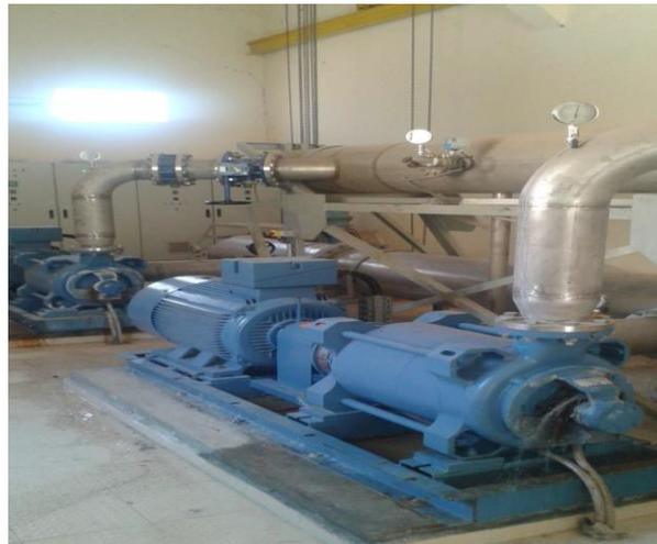
Figure 20: Les pompes de refoulement
