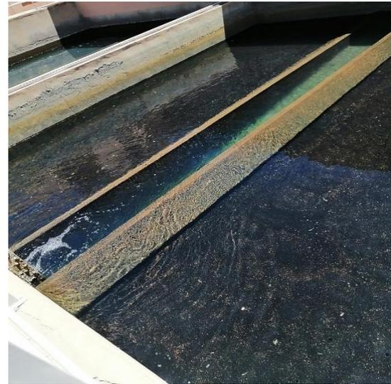
Figure 15 :Les filtres à sable
