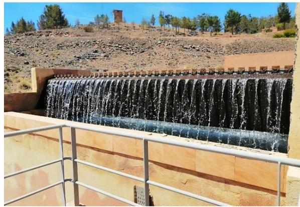
Figure 9: Cascade d'aération
