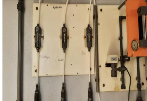
**Figure 42 : Mélange et passage d'eau chlorée**
