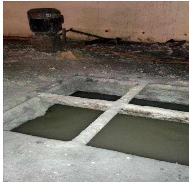
Figure 30: Bac de préparation de sulfate d'alumine
