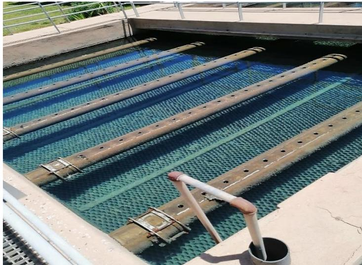
Figure 14: Décanteur lamellaire
