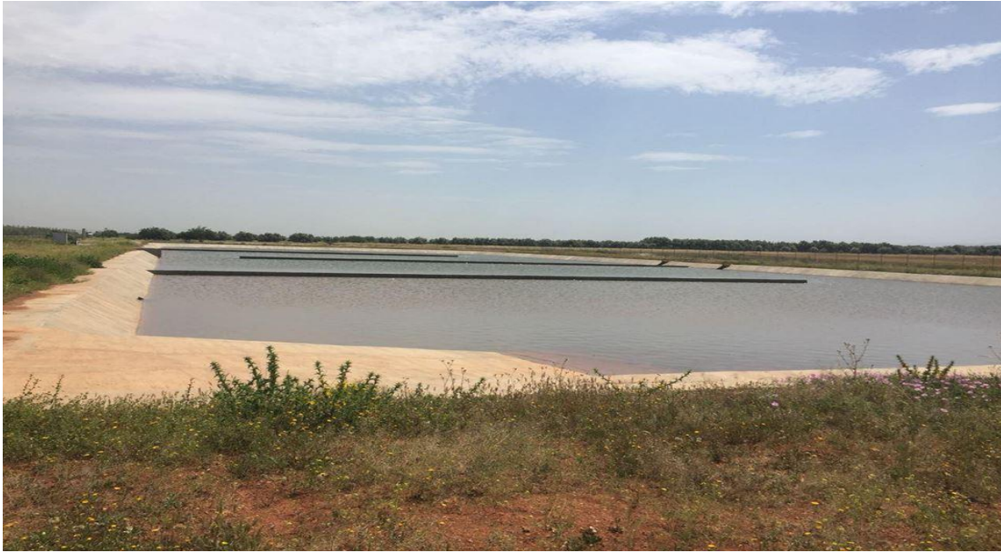
Le bassin de régulation 8000 m 3
