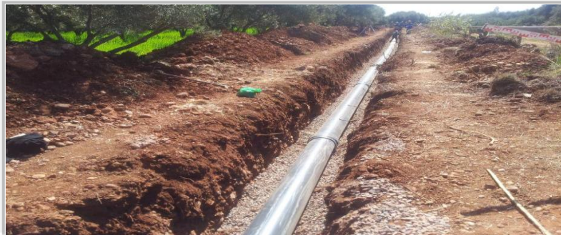
POSE DE CONDUITES
