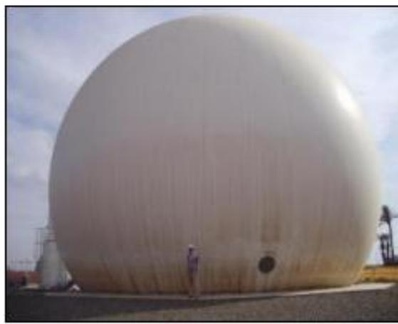
**Figure9 : Stockeur de gaz de la STEP de Marrakech (gazomètre) (image. Google)**
