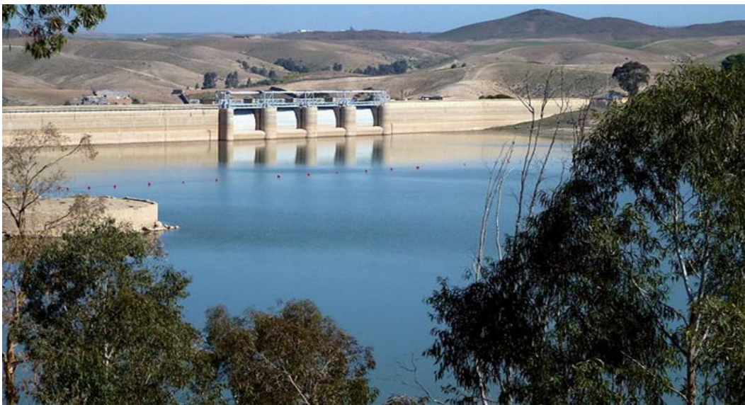
Figure 12 : Vue de la retenue du barrage LallaTakerkoust.
