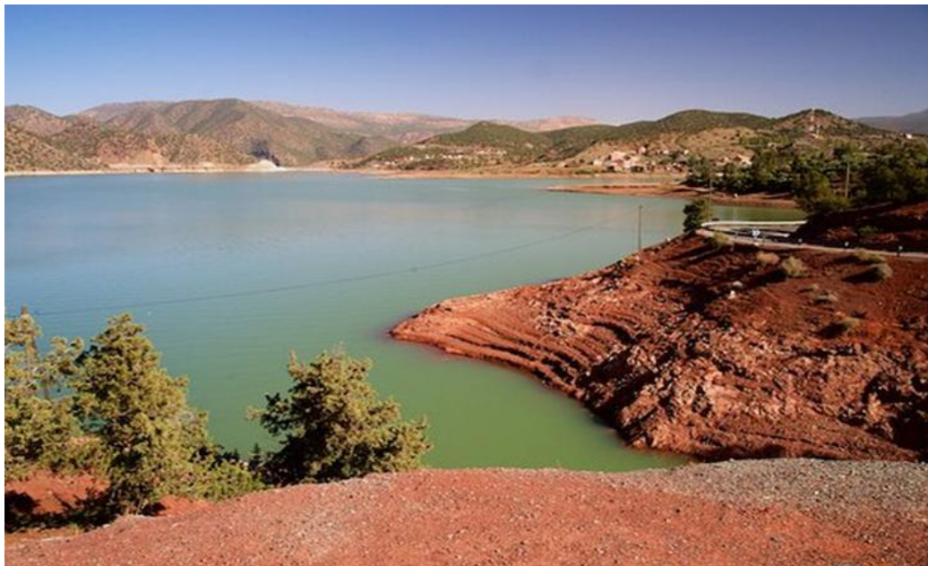
Figure 13 : Vue sur le barrage d'Ouirgane.
