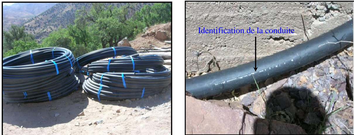
Fig. 13: Conduite PEhd DE* 63 PN* 10 (à trait bleu)
